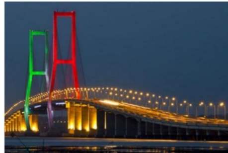
Gambar 4. Jembatan Suramadu Sumber: (Prabowo, 2018)
